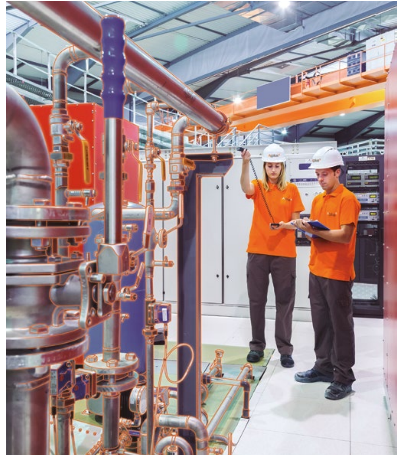
Control de calidad y asistencia técnica en edificios.
