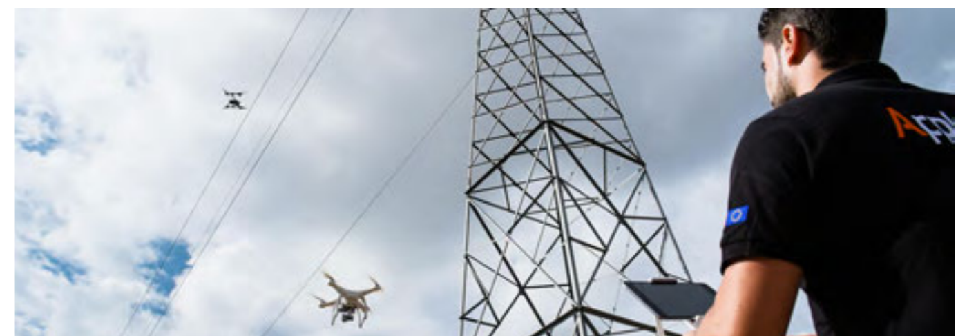
Inspección con drones en líneas eléctricas
