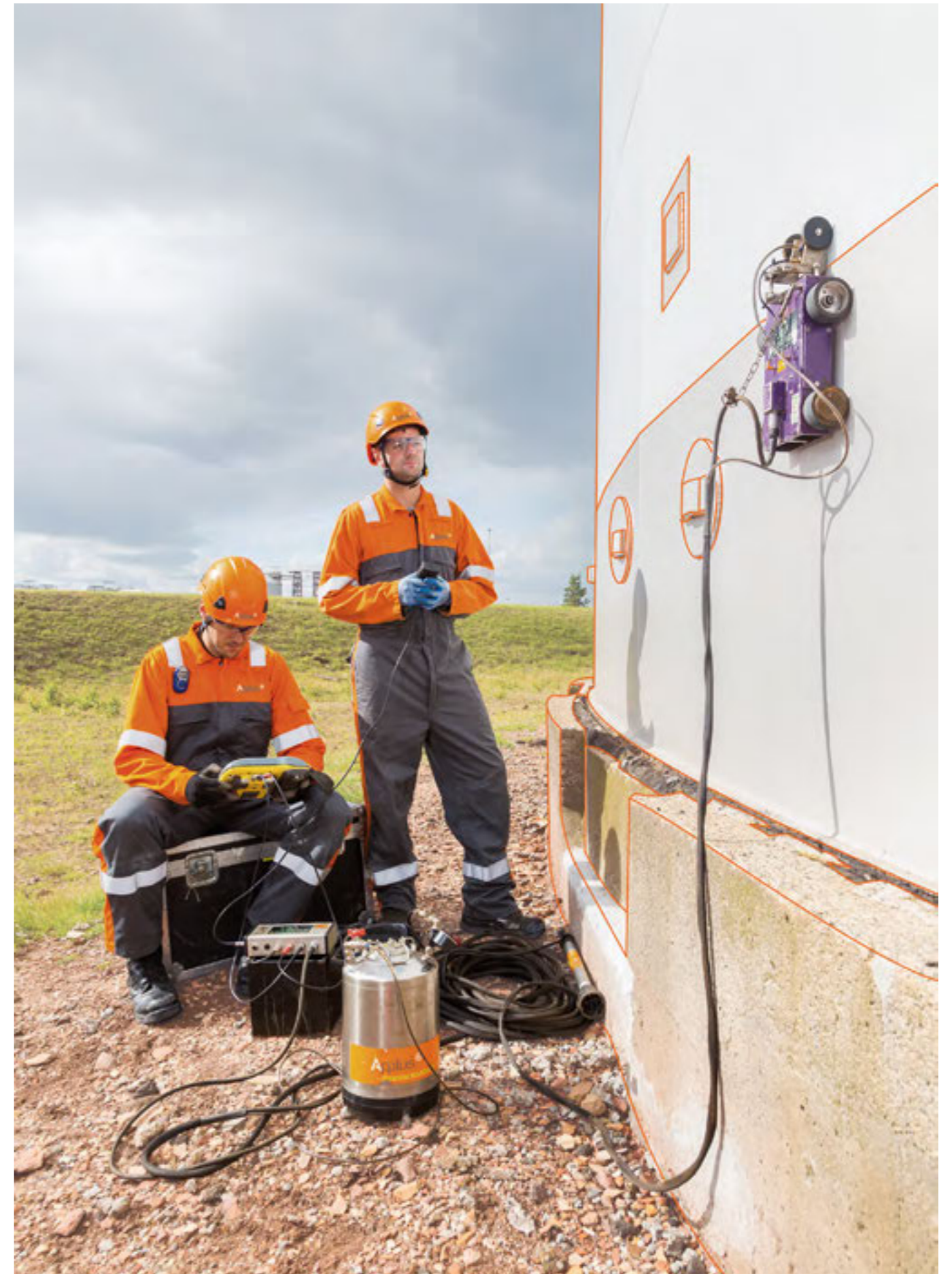
Ensayo no destructivo en un tanque de almacenamiento
